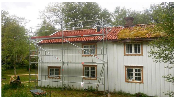
Rensing av tak og utbedring av vindusfag .
