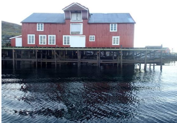
Salterikaia før montering av fenderverk
