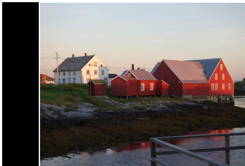
Den tette trehusbebyggelseen rundt Fiskebruket på Flatholmen
