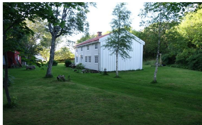
Vågsengtunet etter håndspåleggelse av hus og hage.
